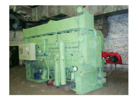
**ТЕПЛОНАСОСНАЯ УСТАНОВКА** тепловой мощностью 4700 кВт на базе двух абсорбционных бромистолитиевх тепловых насосов с огневым обогревом АБТН-600Т ТЕПЛОСИБМАШ.
